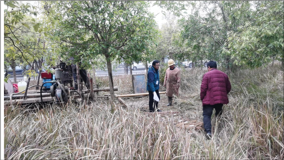
232 厂房场地现状
