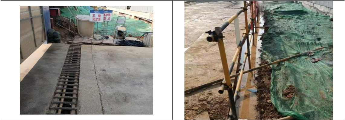
临时排水沟及苫盖措施
