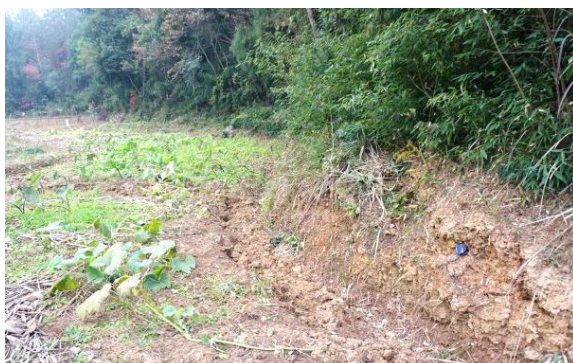
图 6.1-4 垃圾渗滤池对岸残坡积
