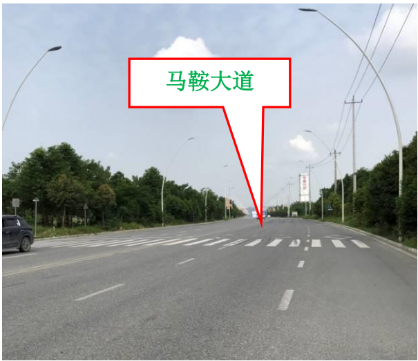
图 1-2 拟建地西侧马鞍大道现状
