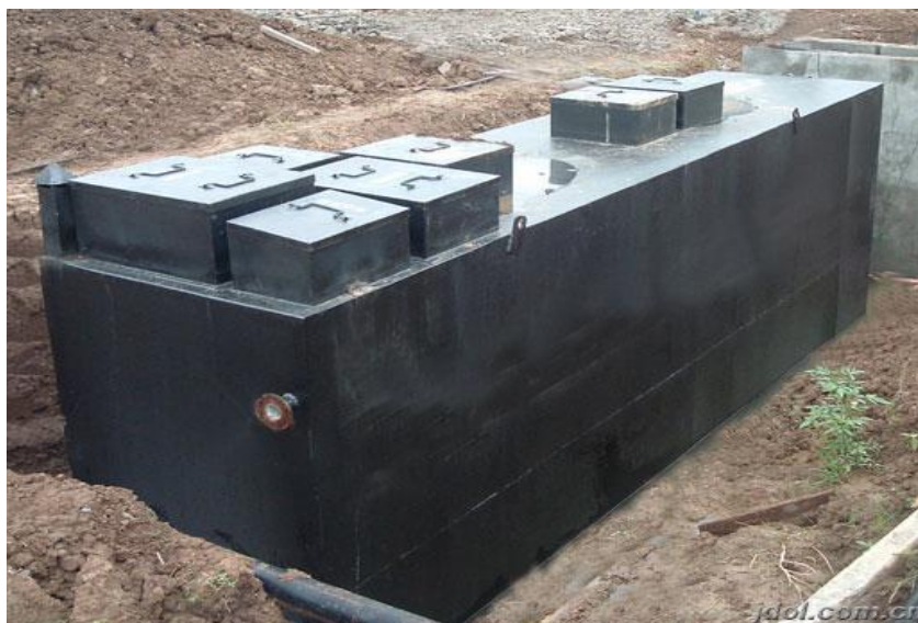
图 5-2 EIC-MBR 一体化设备示例——美好乡村地理式一体化设备
