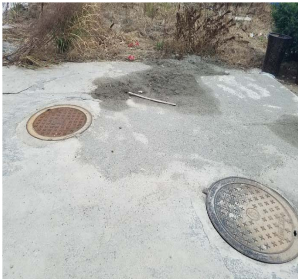
积家工业园生活废水预处理池
