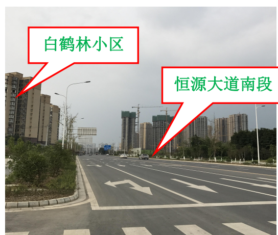
图 1-6 项目东面的恒源大道南段现状
